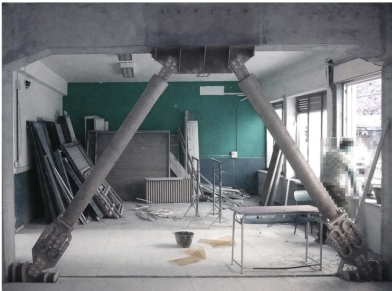
Installazione di controventi dissipativi
